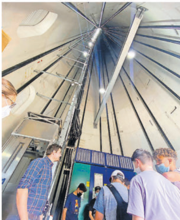
140 Meter geht es im Inneren der Windanlage sieben im Windpark Schiffweiler in die Höhe. Obendrauf sitzen noch die Rotorblätter, die jeweils 45 Meter messen Markus Müller von Enovos (links) erklärt den Schülern viele Fakten rund um die Anlage. FOTO: JANA RUPP
