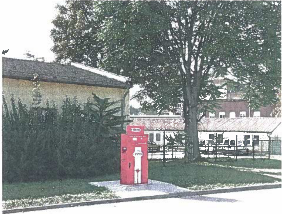
Im Frühjahr sollen in Neunkirchen die ersten öffentlichen Ladesäulen stehen. Vier sind insgesamt geplant, zwei weitere in Spiesen-Elversberg und in Schiffweiler folgen. FOTO: WALTHER-MERKE F. WALTHER/GRABU
